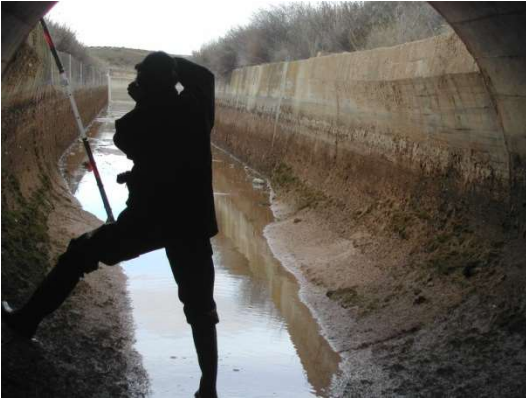
Javier Sampedro Gibanel "Revisando túneles" (túnel nº 8 de la acequia de Terreu, en Castelflorite –Huesca-)
