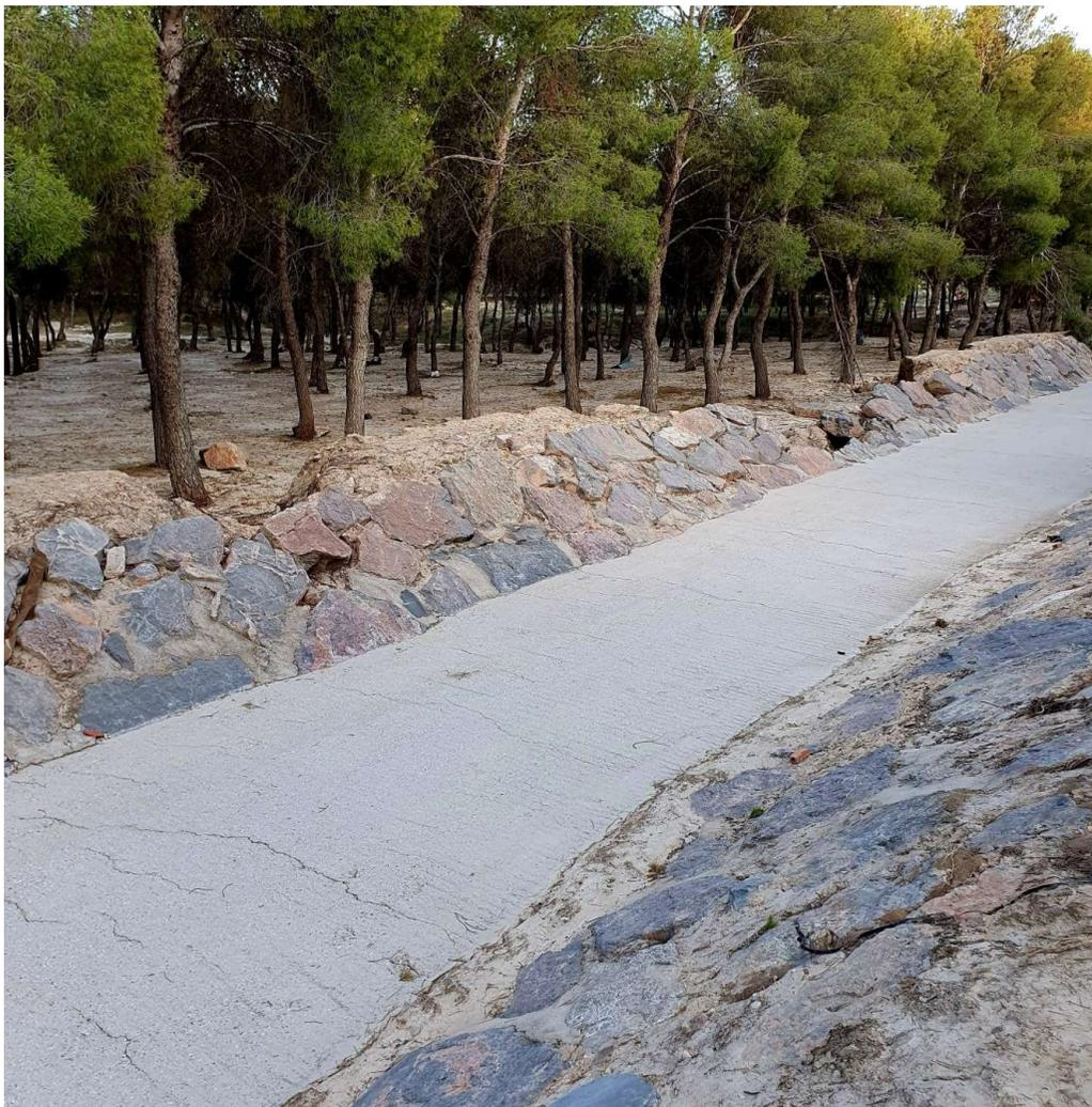
17/7/2023: Puntos de rotura de canalización de escollera en el barrando de la Muerte
